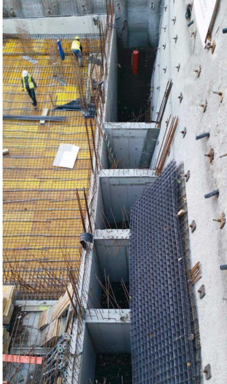
Die druckfeste und formstabile Liapor-Hinterfüllung verringert den Umgebungsdruck auf das Gebäude.
